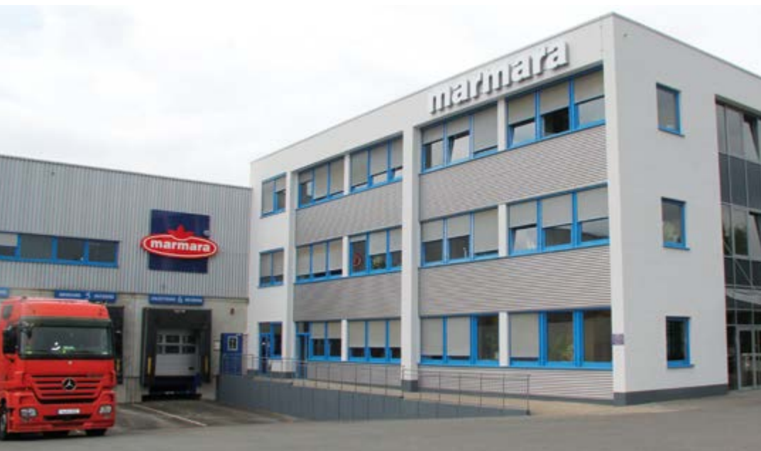
Logistikzentrale von Marmara in Ratingen
